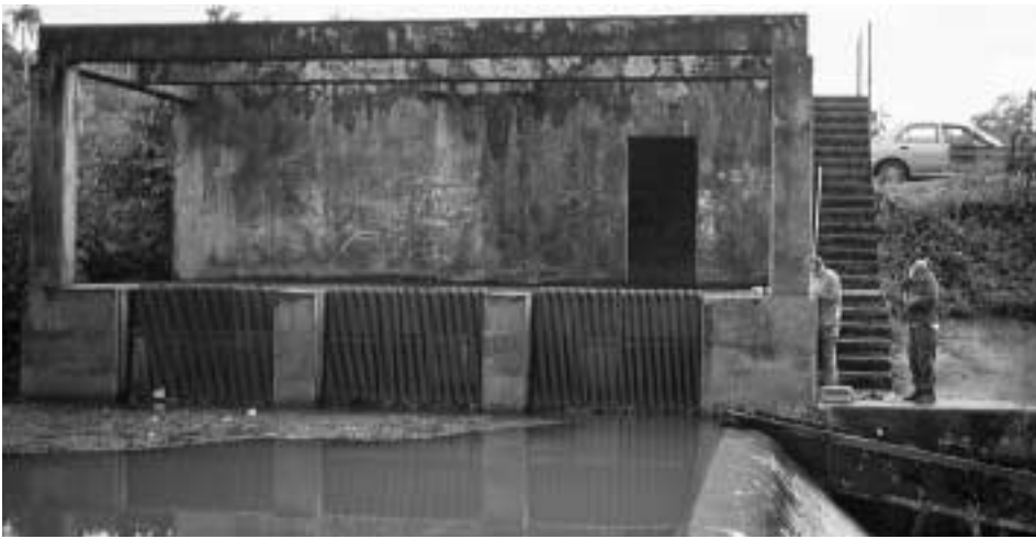
Figura 5. Escalera para peces en el Río Espíritu Santo. La escalera para peces se ve en la esquina inferior derecha, debajo de las personas en la foto. Parece una rampa.
